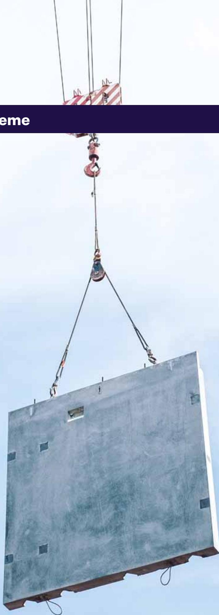
Das HALFEN DEHA KKT Kugelkopf-Transportankersystem ist ein universelles Schnellkupplungssystem zum Transport von Betonfertigteilen aller Art. Mit Ankerlasten von bis zu 45t eignet sich dieses System selbst für die anspruchsvollsten Anwendungen.
