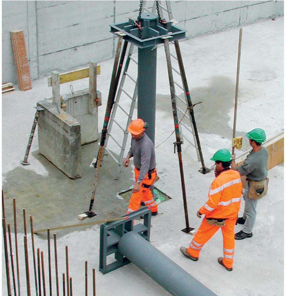
Ancon SH Stahlpilze gibt es in 3 verschiedenen Grundformen (siehe unten). Die genauen Abmessungen müssen jedoch nach den entsprechenden statischen Gegebenheiten bemessen werden.
