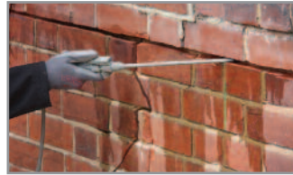
2. Reinigen und spülen Sie die Schlitz mit Wasser bis das Mauerwerk ausreichend befeuchtet ist
