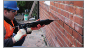
5. Ziehen Sie eine weitere HeliBond Schicht über den freiliegenden HeliBar Stab und glätten Sie die Fuge sorgfältig
