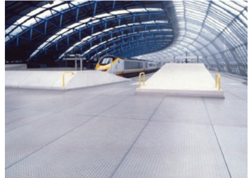
Projekt: Waterloo International Terminal, GB
