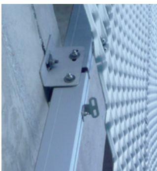
Befestigungselemente für Fassadenverkleidungen (Fassade: James and Taylor)
