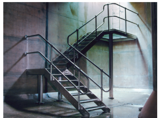
Aufgänge, Laufstege und Leitern
