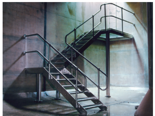
Aufgänge, Laufstege und Leitern
