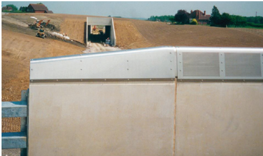
Dekorative Brückenabdeckungen mit Befestigungen. Projekt: Schienenanbindung Ärmelkanaltunnel, GB (Ausführendes Unternehmen: Carillion)
