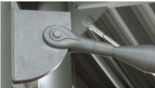
Verbindung Druckstabsystem an Anschlussblech
