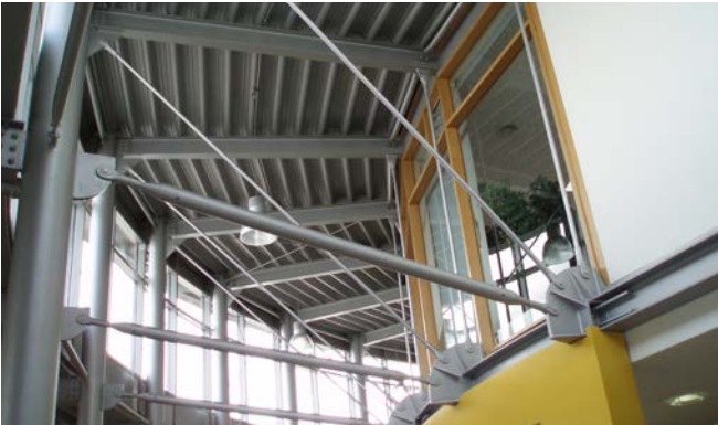
Abstützung zwischen äußeren Stahlstützen und innen liegenden Stahlträgern
